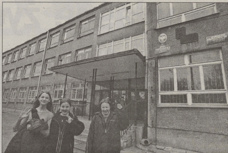
Budynek szkolny przy ul. Kamiennej
