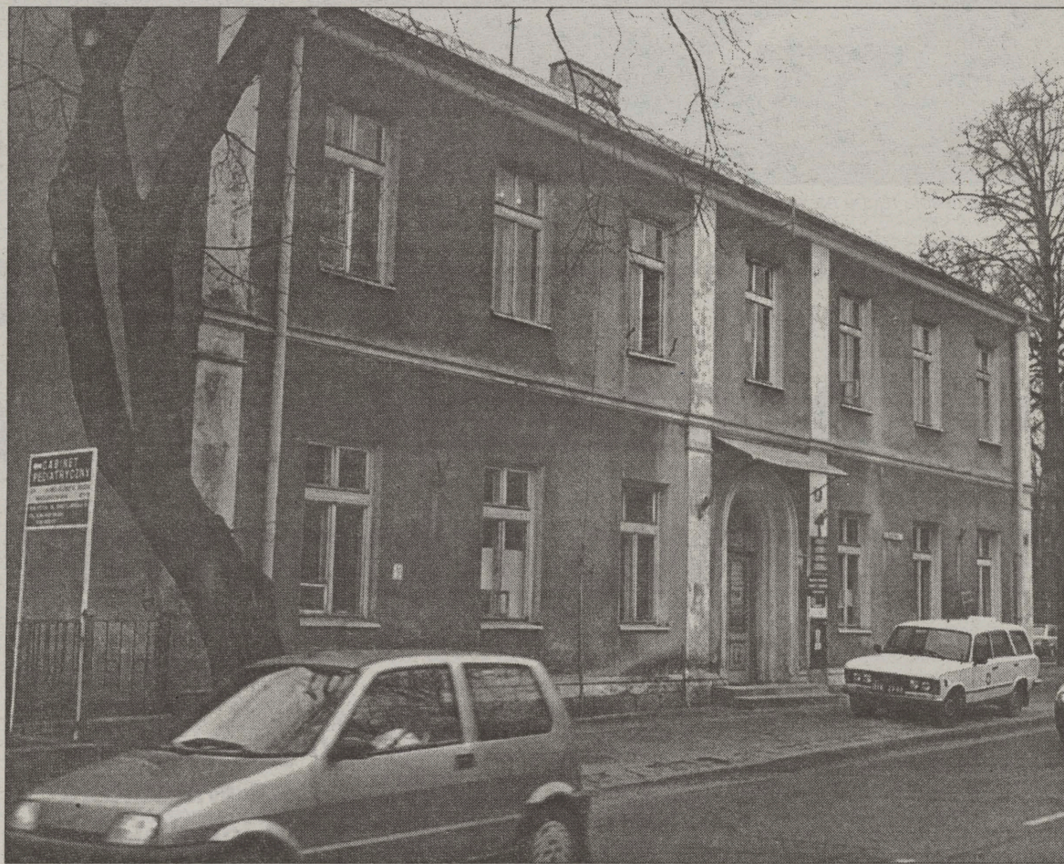
W ramach oszczędności SMZOZ wyprowadzi się m.in. z budynku przy ul. Świętojańskiej. Pracę straci też ok. 100 osób.
