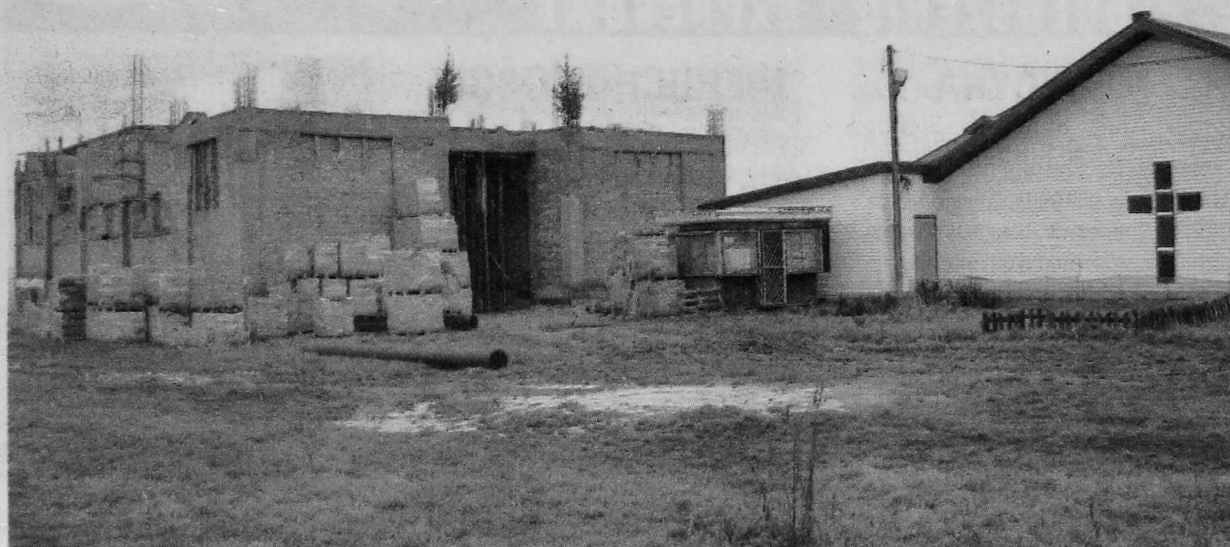
Budowa Kościoła pod wezwaniem Świętego Andrzeja Boboli przy ul. Wąskiej w Łomży
