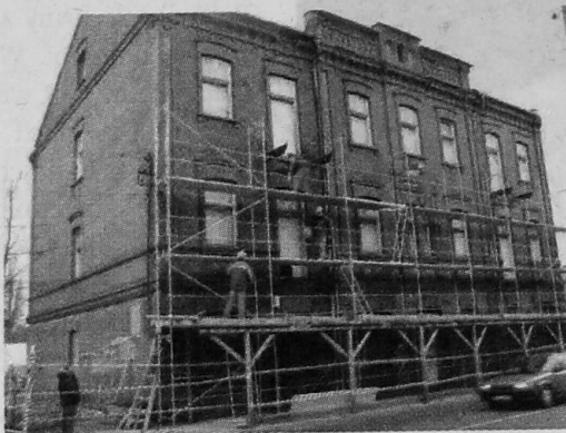
Widok robotników na rusztowaniach ucieczył łomżan
