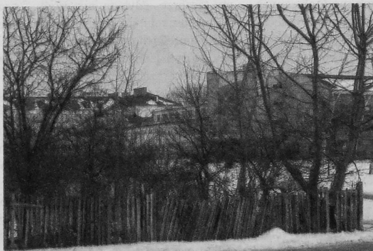
Plac, na którym miał stanąć kompleks hotelowo-gastronomiczny
