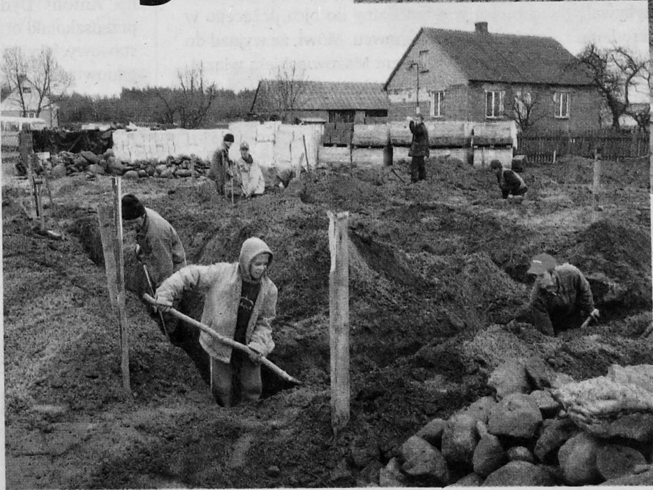
Radek (z lewej), Kamil i Łukasz (w głębi) pracują przy wykopach
