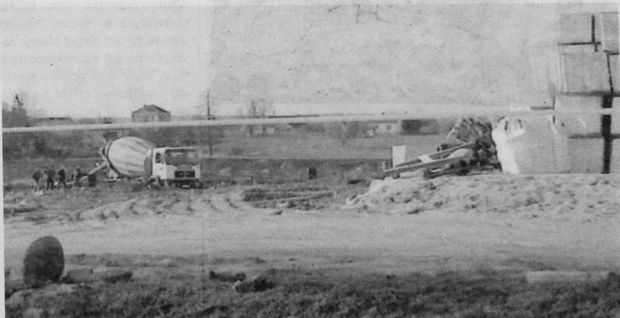
W piątek, 6 kwietnia, robota szła pełną parą
