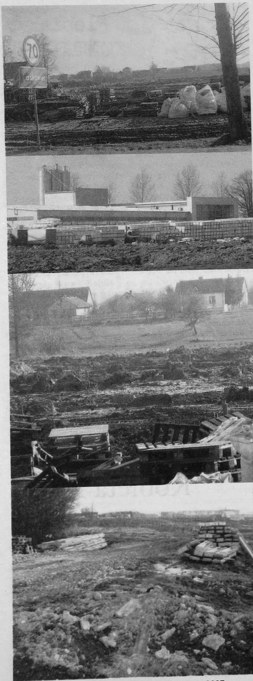
Teren budowy, zdjęcia wykonane 25 marca 2007 r.
