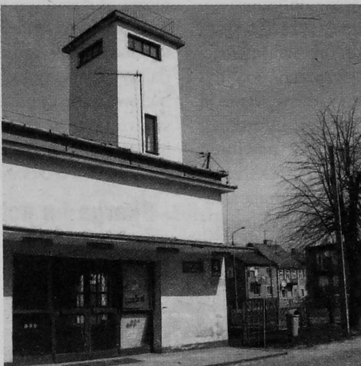
Remontowany od roku budynek Gminnego Ośrodka Kultury w Stawiskach
