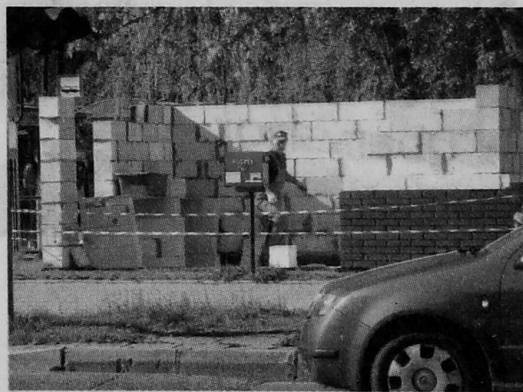
„Tymczasowa budowla” przy al. Legionów i M. Skłodowskiej – Curie z pustaka, z zewnątrz wzmacniana cegłą klinkierową.
