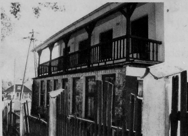
Zrujnowany zajazd „Raj” przy ul. 1 Maja
