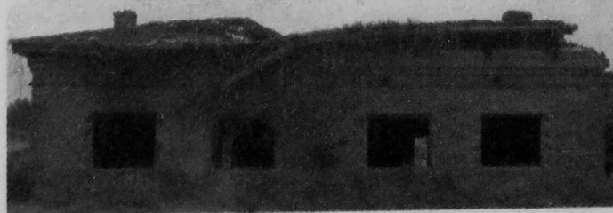
Zabytkowa wartownia 8 czerwca 2007 r.
