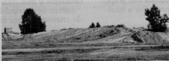
Budowa zbiornika w Czerwonym Borze
