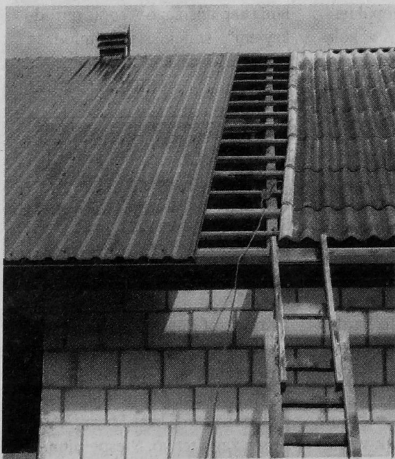
Frąckiewiczowie postanowili na przyjazd prezydenta położyć blachę na dachu obory
