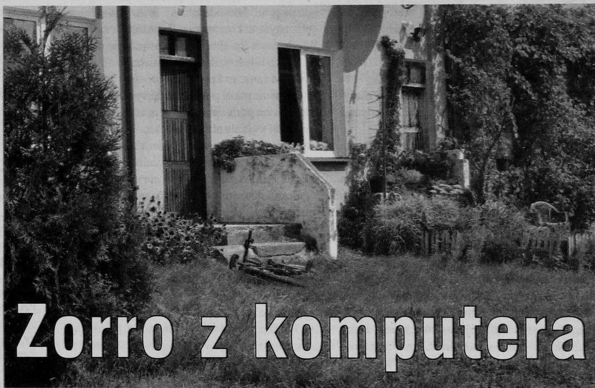
Zwaśnieni nauczyciele mieszkają przez ścianę w służbowych mieszkaniach w budynku szkolnym
