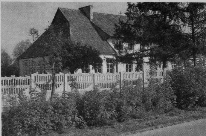
Powtórnie opuszczona szkoła w Gielczynie
