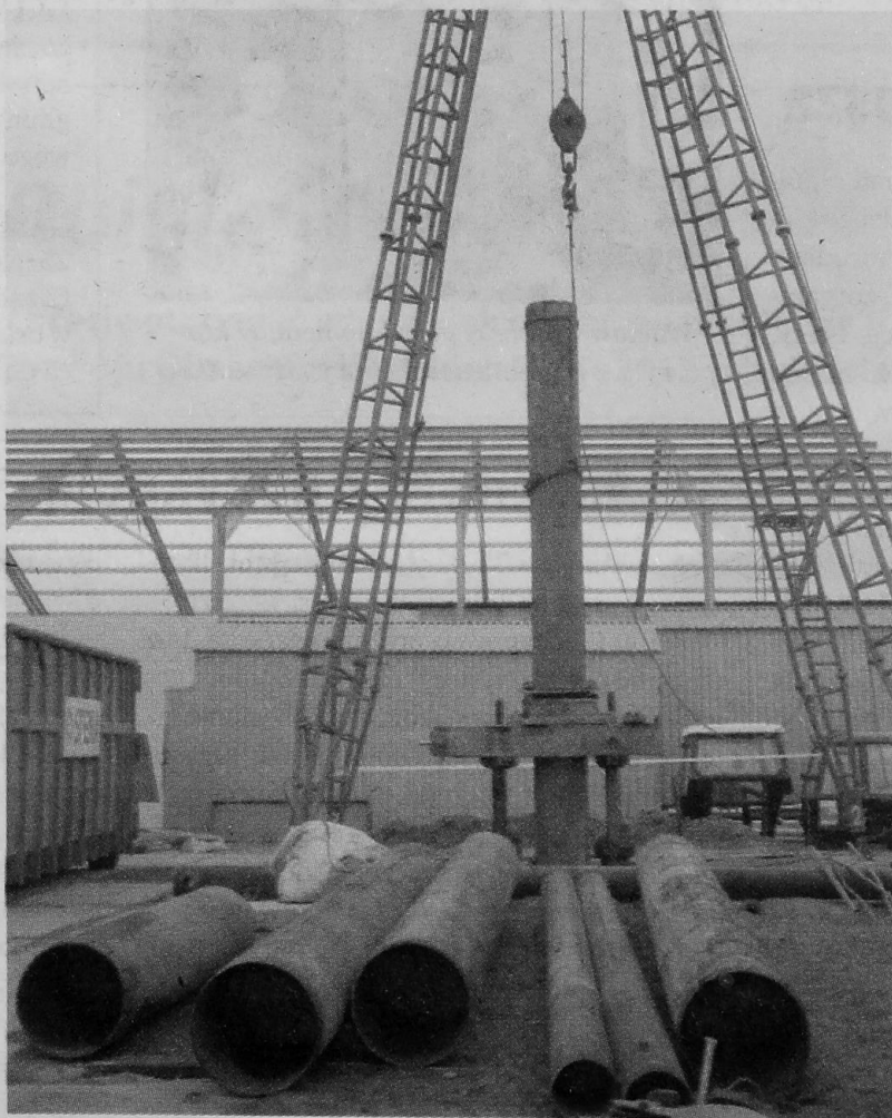
Trwające miesiąc prace przy likwidacji studni w Smolnikach, w poniedziałek zmierzały do końca
