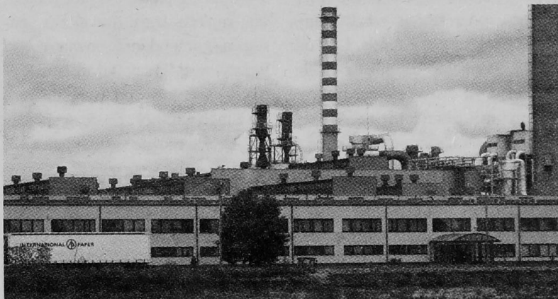
W tym miejscu, obok zakładu płyt wiórowych, powstanie Grajewo II.
