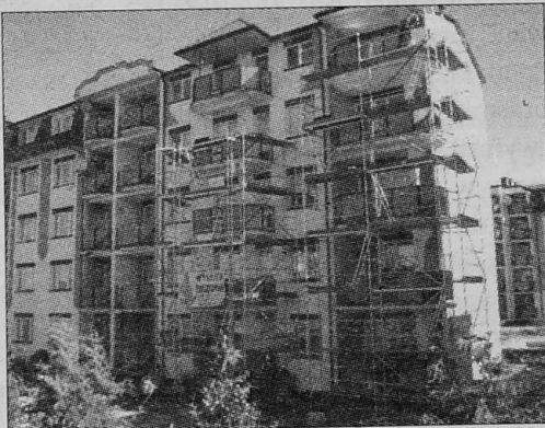
Ten nowy blok jest remontowany z powodu wady konstrukcyjnej w postaci braku wodoszczelnej izolacji na balkonach
