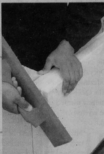
Wyrównywanie i ścinanie narożnika
