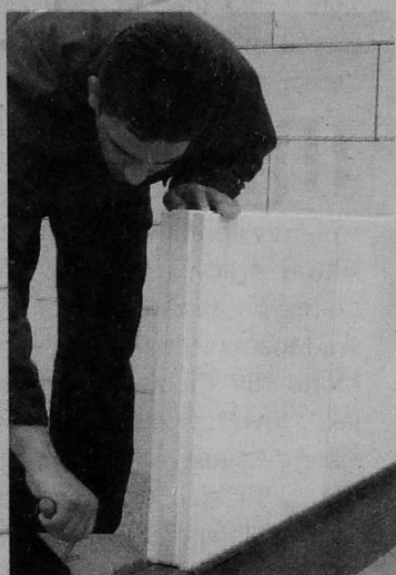
Układanie pierwszej warstwy
