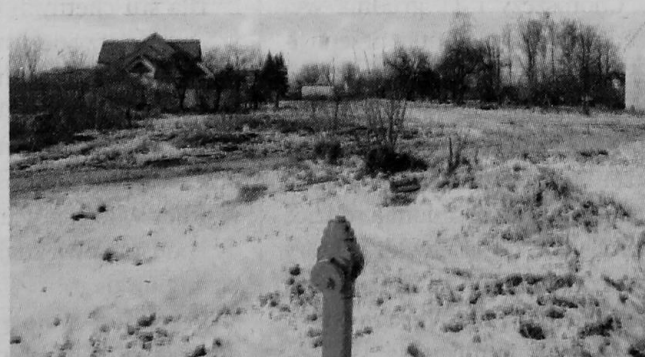
Wytyczone są już ulice, pojawił się wodociąg, ludzie zaczynają budowy
