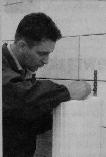
Łączenie płyty PSM do ścian prostopadłych
