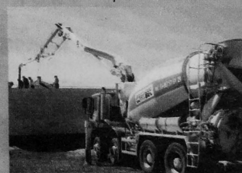
Wylewanie warstwy betonu
