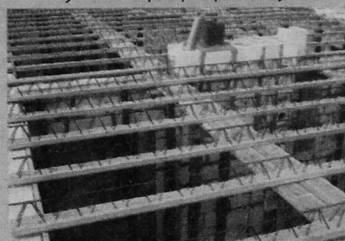
Układanie belek stropowych
