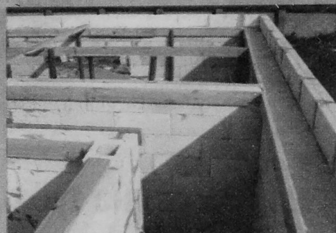
Wykonanie podpór poziomych
