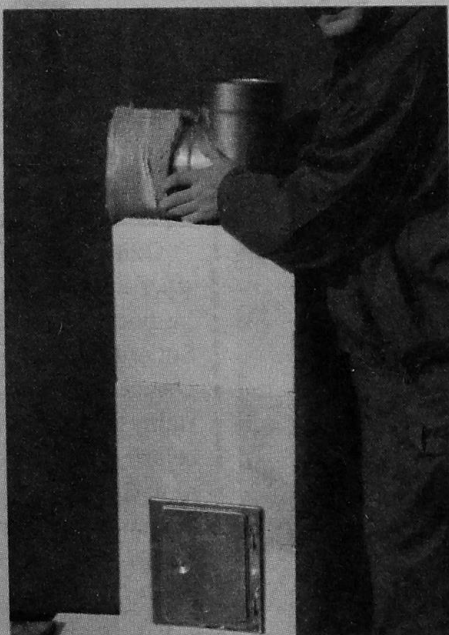
Montaż trójnika i elementów izolacji do podłączenia kotła.
