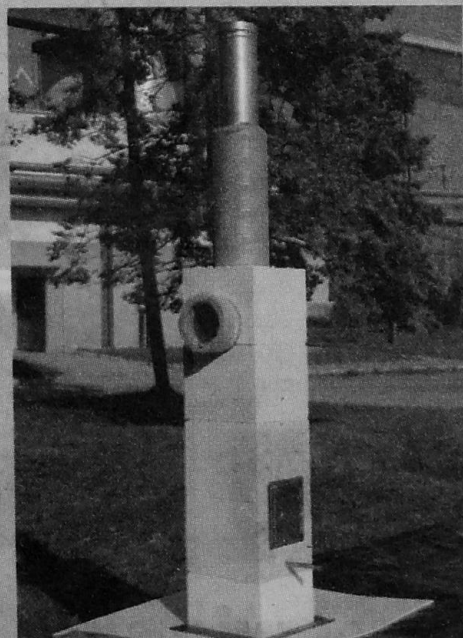
Widok zmontowanej dolnej części komina.
