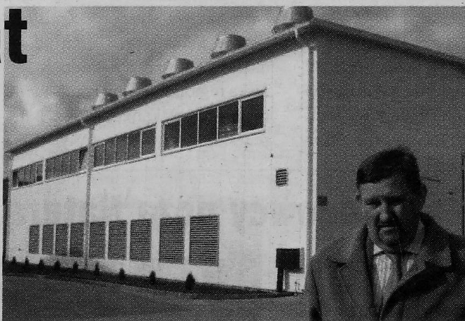
Prezes Grzegorz Lewańczuk przed budynkiem, w którym jest nowa instalacja utylizacji osadów
