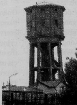
Licząca ponad 50 lat łomżyńska wieża ciśnieniowa
