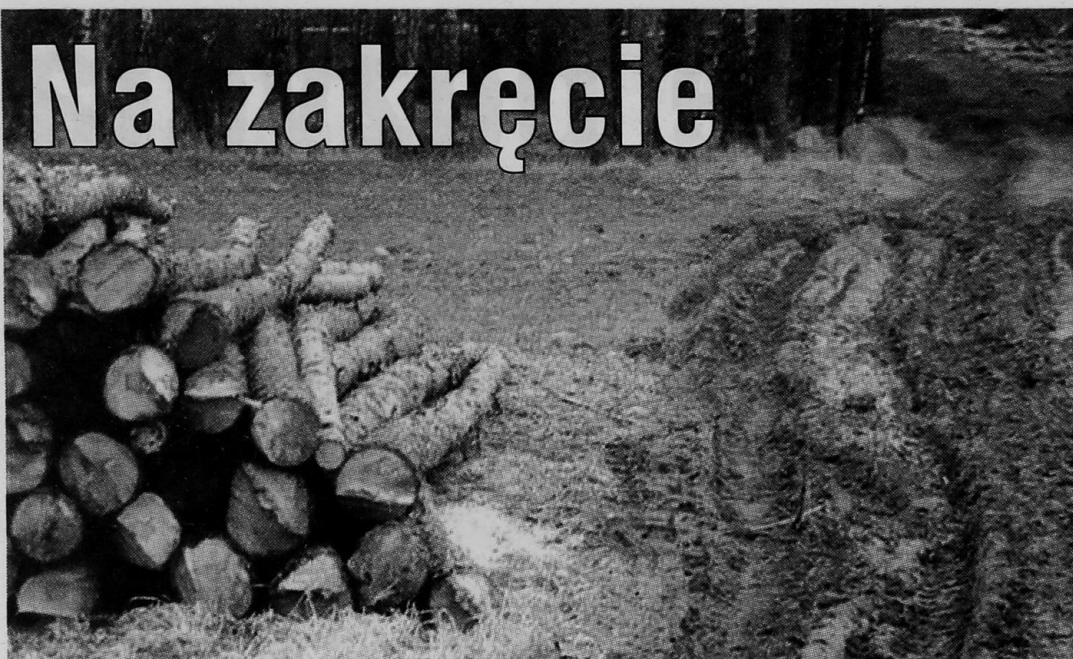
Rozjeżdżona droga w Łębkach Małych
