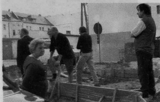
Mieszkańcy bloków z Pocztarskiej i Rządowej przy zaczętej na środku podwórza budowie śmietnika
