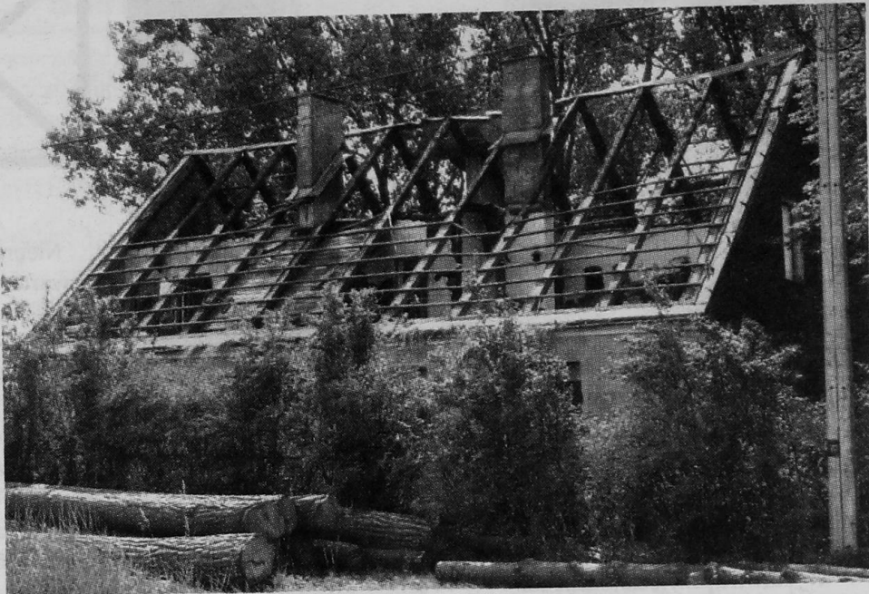
Pożar opuszczonego budynku szkoły rolniczej rozpoczął serię pożarów w Jedwabnem
