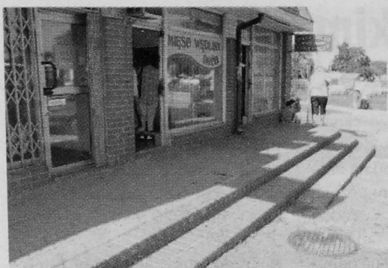
Z tej studzienki, kilka kroków od stanowiska dla wysiadających z autobusów, od kilku lat wylewają się fekalia
