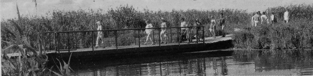
Kładka w Waniewie ma 1050 metrów!
