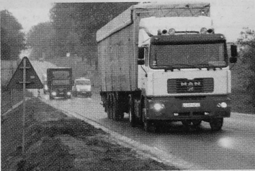
Gdzie było pobocze, jest betonowa rynna
