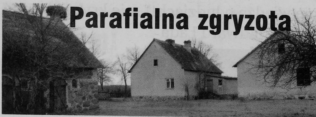
Budynki parafialne wymagają remontu
