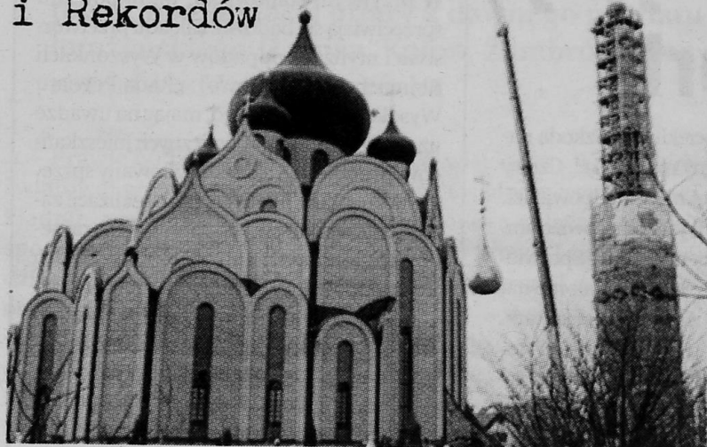
Moment podnoszenia kopuły przez potężny dźwig
