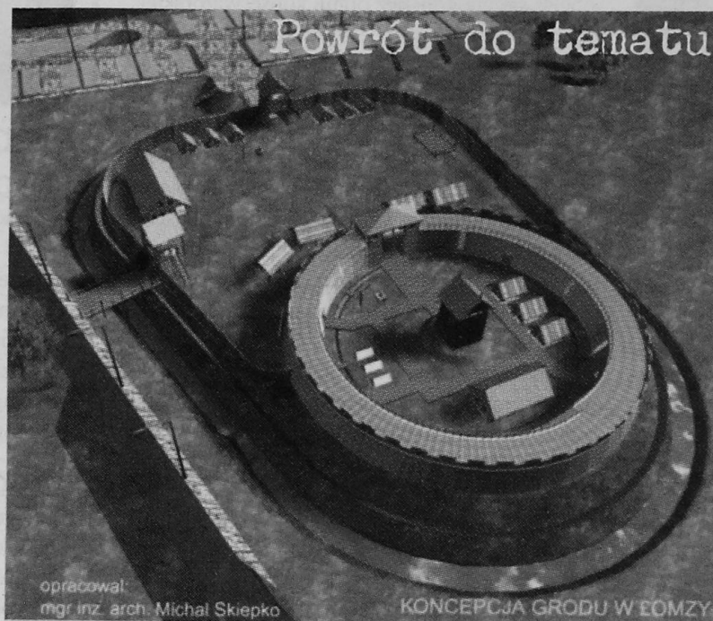
Zbyt kosztowna wersja grodu z potężnym wałem i ukrytymi w nim budowlami z żelbetonu, głęboką fosą i dwoma mostami
