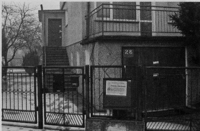
Dom na ul. Pułaskiego w Łomży, który doprowadził do zbrodni, stoi pusty...
