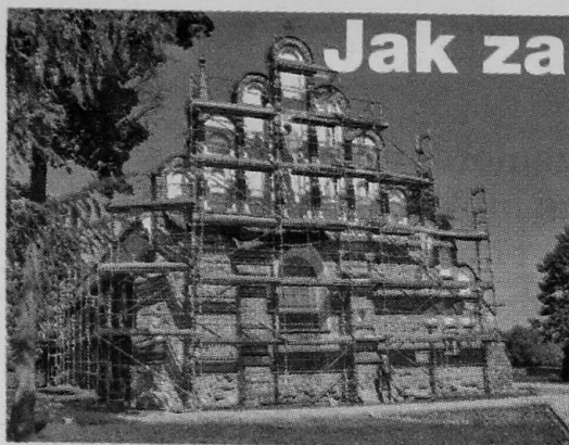
Prace konserwatorskie na elewacji frontowej
