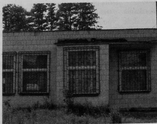
Budynek byłego sklepu, w którym będzie świetlica
