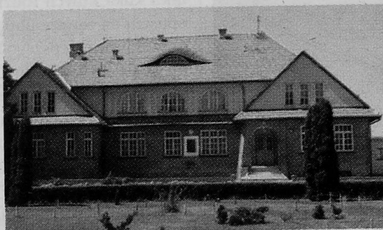
Zabytkowy budynek szkoły w Krzyżewie, w sąsiedztwie którego powstanie biogazownia
