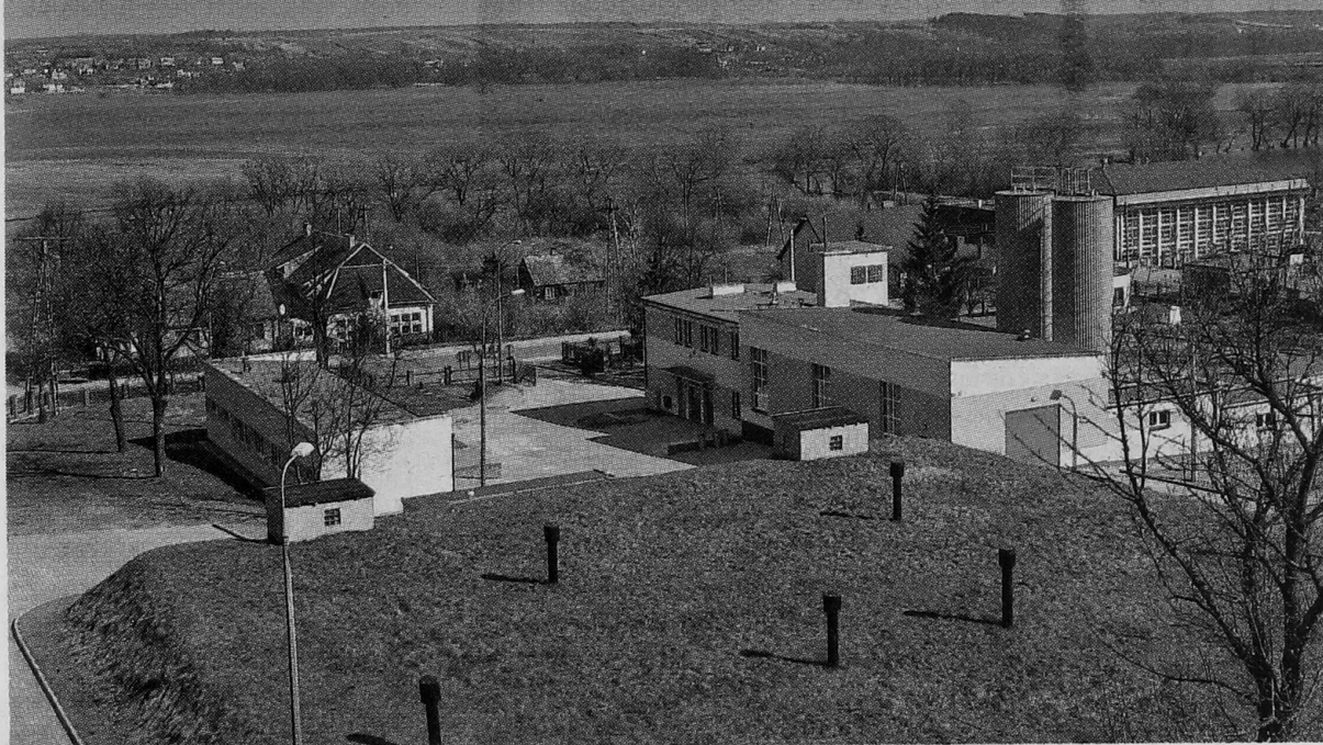
Nowoczesna stacja uzdatniania wody na ul. Rybaki w Łomży
