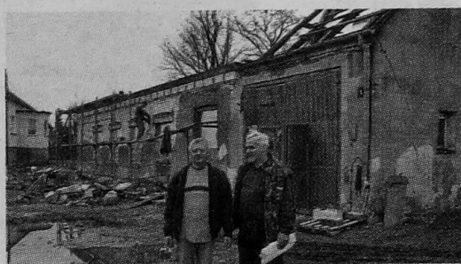
Wiesław Zalewski (z lewej), jak wszyscy mieszkańcy Przytuł, nie może się doczekać nowej remizy; z prawej wykonawca prac Borys Sawinda z Krasnosielca (pow. makowski)
