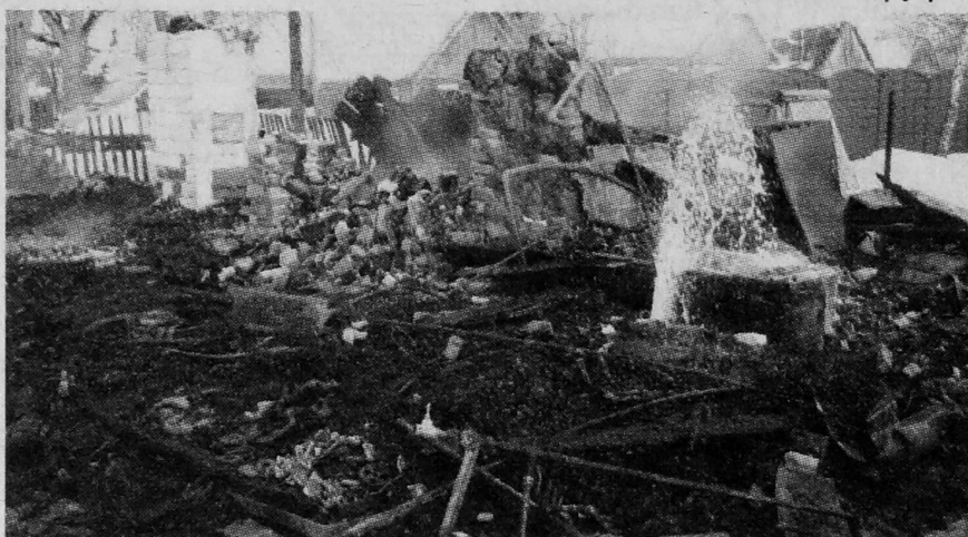
Zgliszcza domu w Kruszyńnianach, w których strażacy znaleźli szczątki gospodarza (lat 81)
