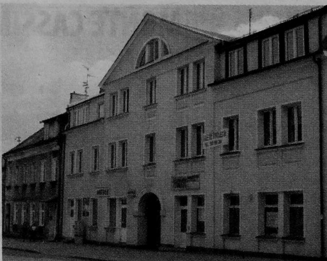
65 lat temu Bruzda i Ryba z piwnic tego budynku przy ul. Kopernika (ówczesna siedziba PUBP) uwolnili około 100 więźniów
