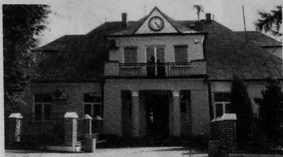
Odnowiona elewacja Urzędu Gminy, symbol powrotu normalności
