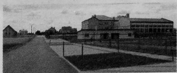
Z myślą o planowanym kompleksie rekreacyjnym z basenem został już położony asfalt na ul. Sportowej i zbudowane parkingi
