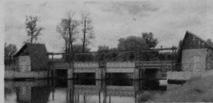
Stopień wodny na Nurcu z małą elektrownią wodną i mostem
