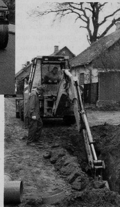
Prace na ul. Świętojańskiej
