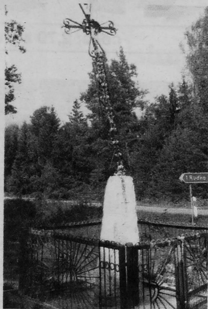
Krzyż w Rudce Skrodzie w trakcie naprawy
