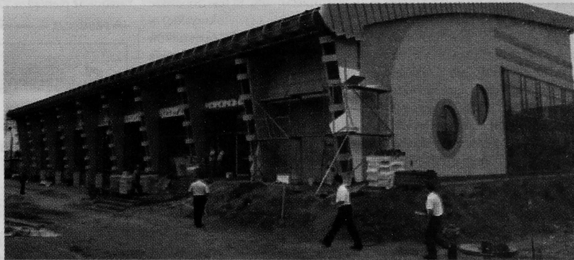
Budowa pływalni na finiszu
