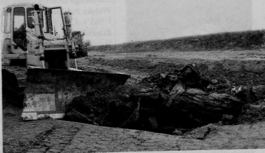
Wrak kradzionej toyoty, odkopany po 13 latach na budowie obwodnicy Zambrowa. Fot. Policja
