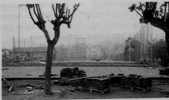
„Orlik” przy ul. 11 Listopada w Grajewie (w trakcie budowy)
