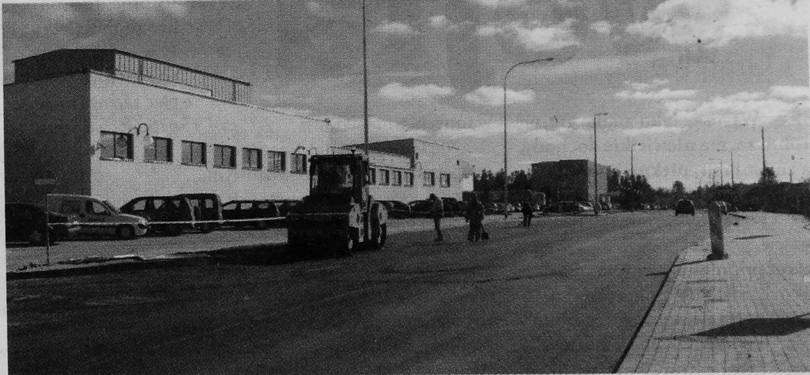
Przebudowa części ul. Elewatorskiej to również efekt realizacji wspólnego projektu miasta i powiatu
