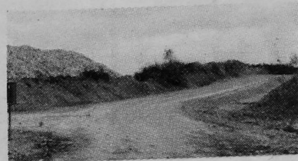
Wybudowany w tym roku odcinek asfaltu do Kędziorowa zaczyna się przy kopalni żwiru
