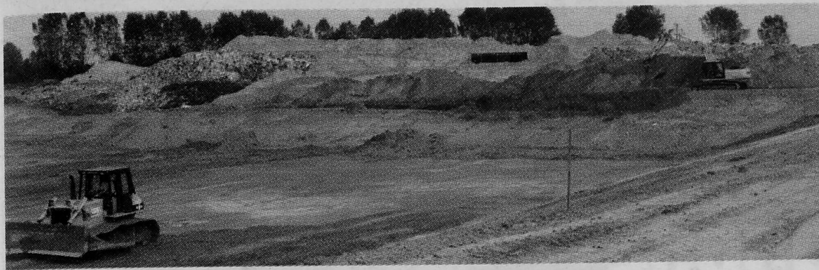
Budowa Zakładu Zagospodarowania Odpadów w Koszarówce
