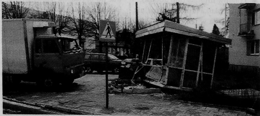
Kiosk w Dąbrowie Białostockiej, staranowany przez pozostawioną na luzie przez pijanego kierowcę ciężarówkę. Fot. Policja
