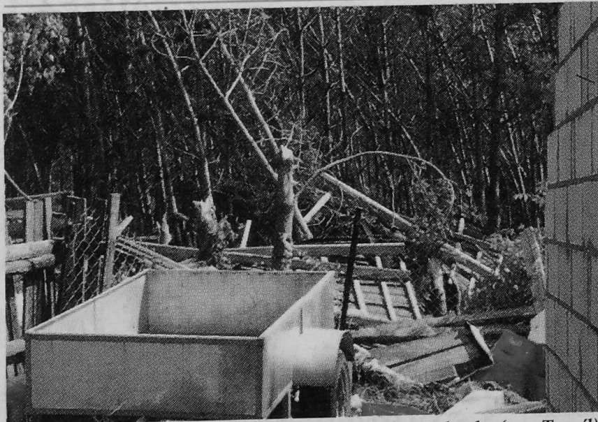
Kapryśny i zaskakujący jest początek lata: we wsi Cieloszka (gm. Turośl) trąba powietrzna zniszczyła murowany budynek (garaż) i fragment lasu
