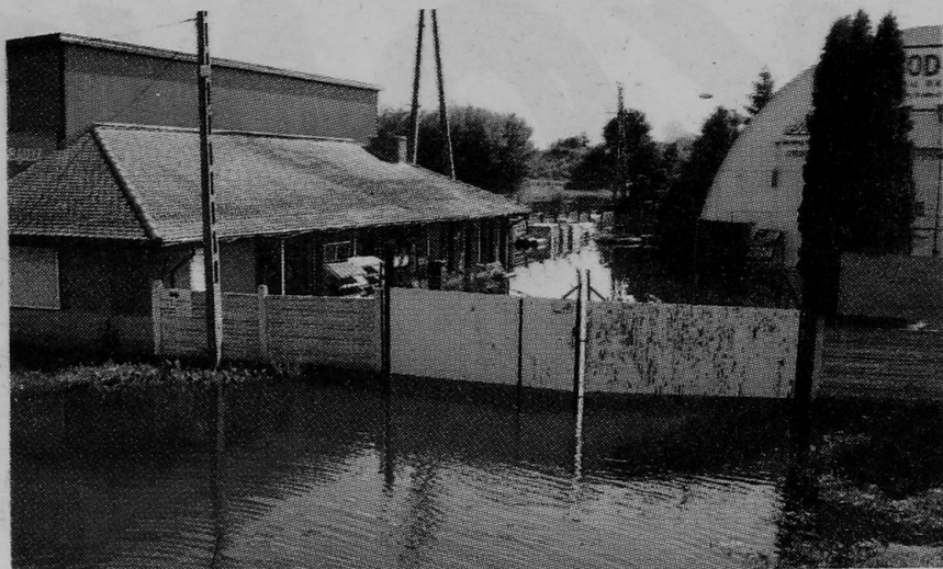
Piątek, 8 lipca: zalane składy budowlane przy moście na Piłsudskiego (dawny Terrazyt)
