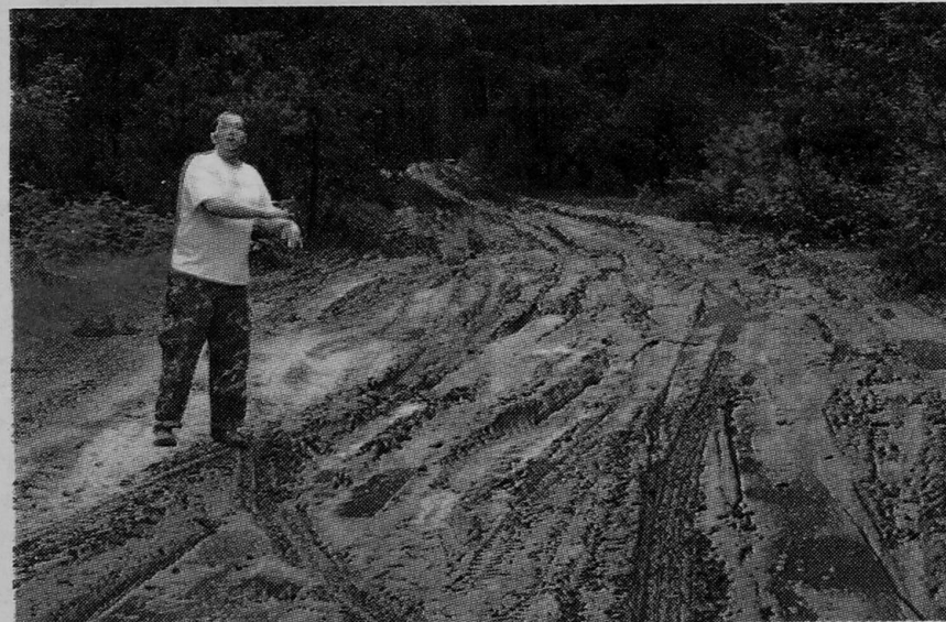
Rafał Jankowski w tym miejscu wyrównał drogę i nawiązał 30 wywrotek żwiru
