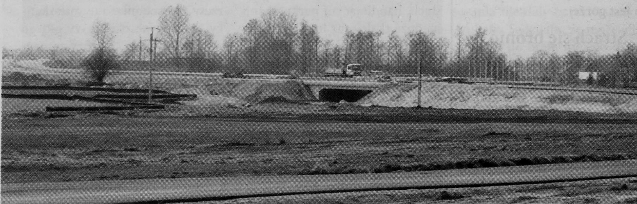
Droga do Wiśniewa będzie krótsza po oddaniu do użytku widocznego w głębi mostu na nowej serwisówce. Nikt jednak nie wie, kiedy to nastąpi
