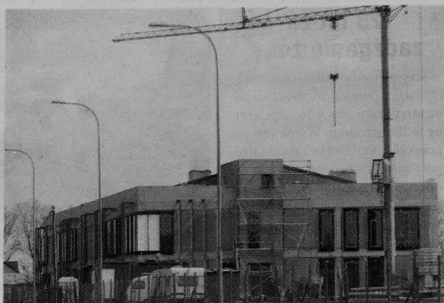
Budowa fabryki sprzętu medycznego
