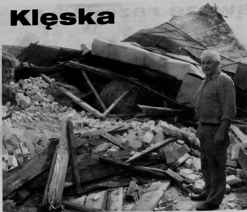
Franciszek Głębocki z Jakaci Dwornej przy zniszczonych zabudowaniach gospodarskich
