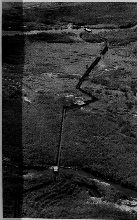
Kładka na rozlewiskach Narwi w Waniewie ma 1500 m długości!
