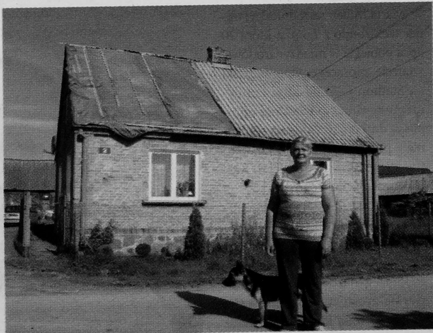
Jadwiga Rogińska przed swoim domem ze zniszczonym dachem, zabezpieczonym przez strażaków z Kupisk
