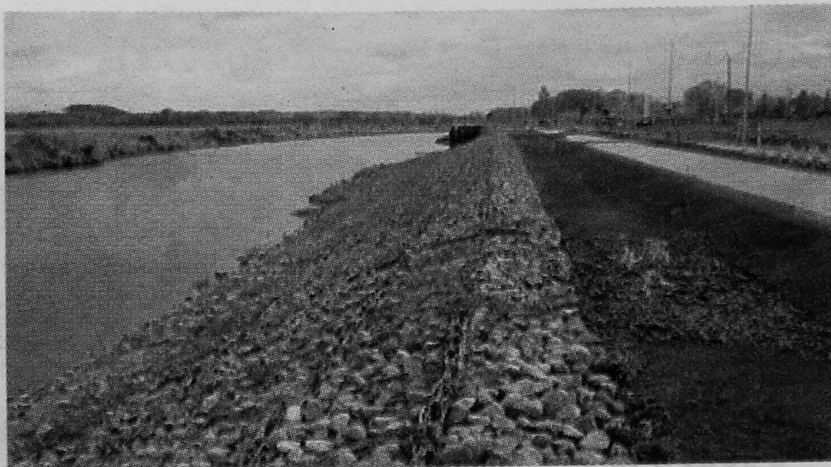
Fragment budowanych bulwarów nad Narwią w Łomży
