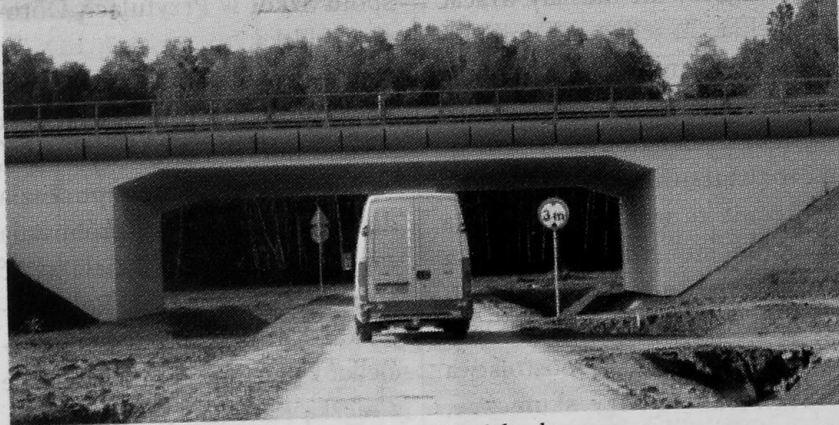
Wiadukt w Nagórkach
